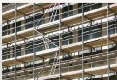
ARBEITSSCHUTZ Dachdecker rüsten auf
